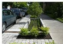
Street runoff infiltration swale دریاچه آب‌سبز در خیابان
