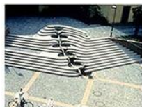
Rain water cascade from downsprout for oxidation آب‌باران از سوراخ‌های آب‌ریز برای اکسیداسیون
